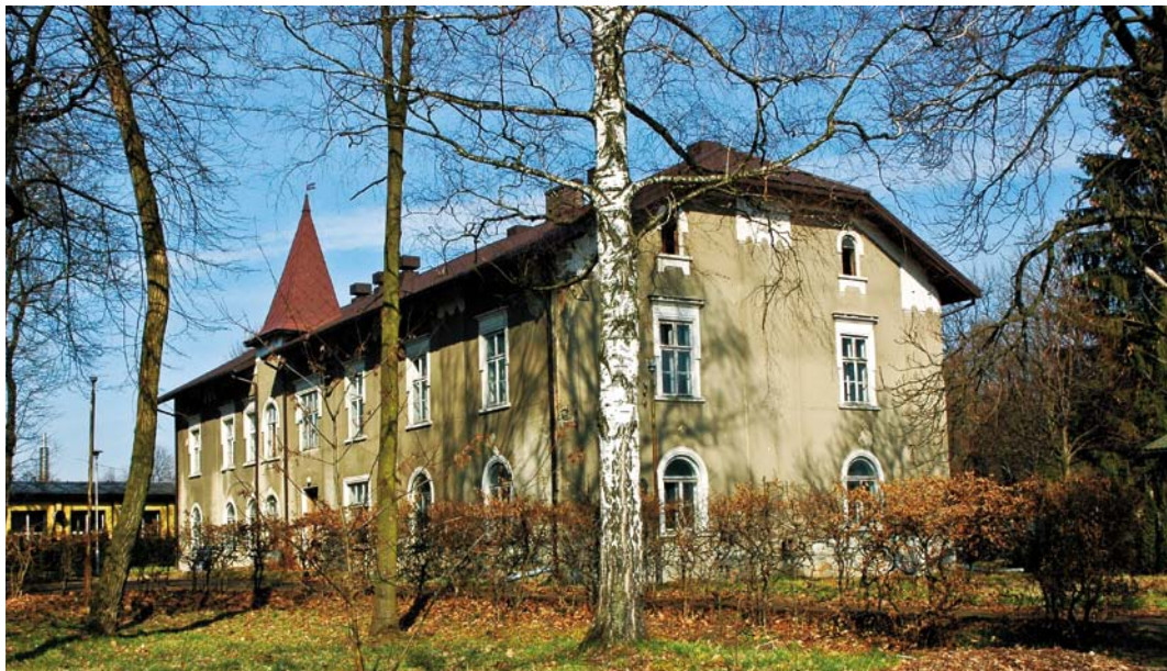
Długa, południowa elewacja dworu znajdowała się od strony dawnego folwarku. Na chorągiewce daszku umieszczono datę powojennego remontu – 1950, fot. A. B. Kutiak, 2016
